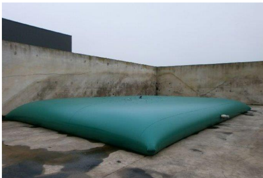
(Citerne souple de stockage de lixiviat )
