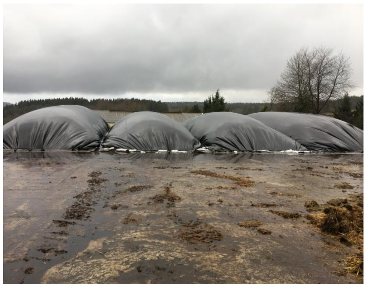
(Les 4 digesteurs couloirs)
